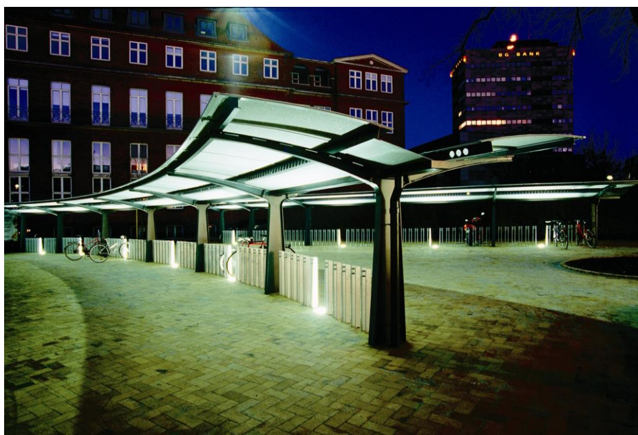
Eksempel på udendørs, spektakulær overdækket cykelparkering. Anlægget er belyst nedefra og anlagt i Odense.
